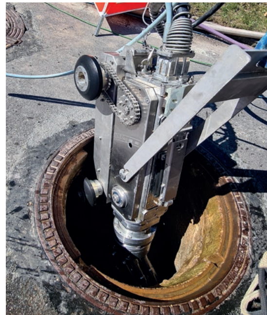
Die DRAIN-JET ROBOTICS® Technologie im Einsatz
